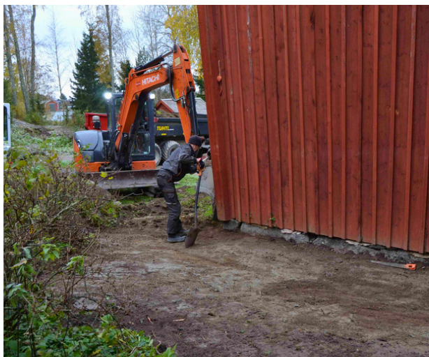
Marklutningen runt loftet korrigeras.
